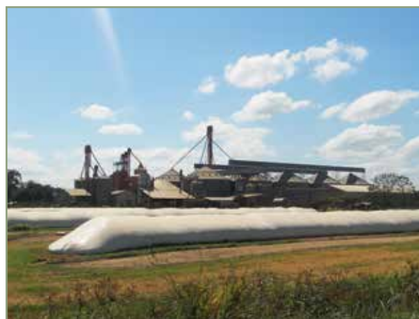
Centro de acopio de grano. Los silos tipo torre tuvieron que ser complementados con silos tipo bolsa para dar cabida a los niveles de producción.
