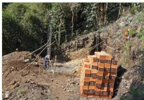
Arena , ladrillo, cemento y fierro. Obras por todos lados.
