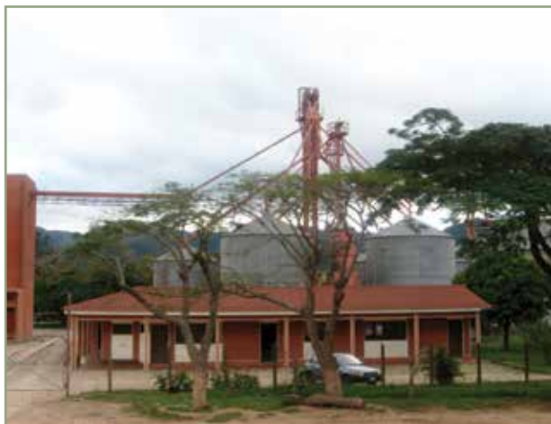
Planta de acopio ubicada sobre la carretera Santa Cruz – Cochabamba, cercanías de Comarapa.
