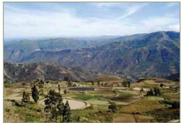
Construcción de atajados familiares en la zona alta del municipio (Torrecillas, junio 2012).
