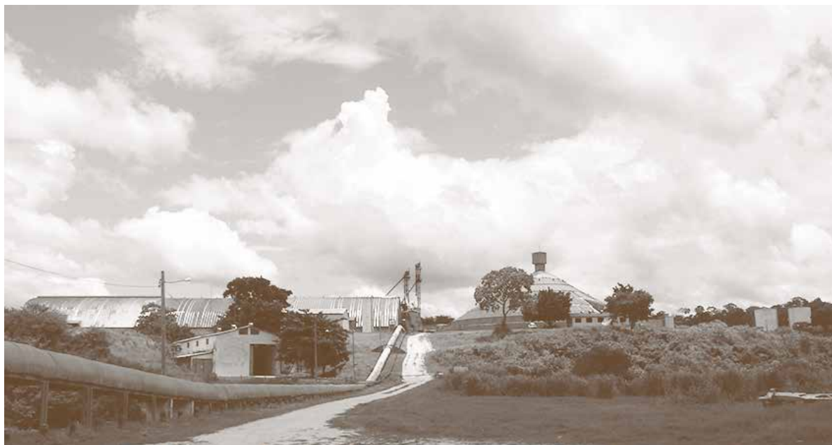
Fotografía 1. Infraestructura desarrollada por Aguirre Agro-Bolivia S.A. en Puerto Aguirre
