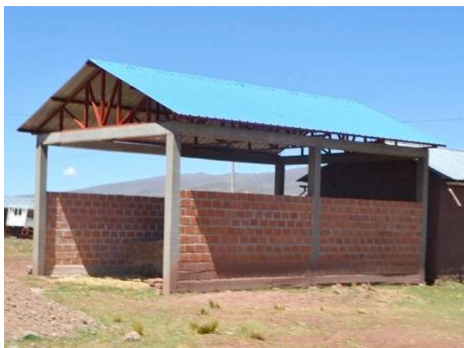
Silo para almacenamiento de forraje
