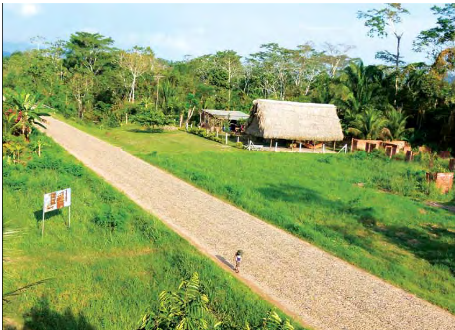
Tierras bajas: vista panorámica de un área ubicada en la población de Palos Blancos, ubicada al norte del departamento de La Paz.
